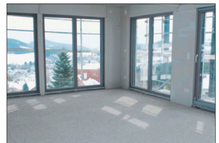
6. Wärmedämmung und Niveausgleich in einem Arbeitsgang.
