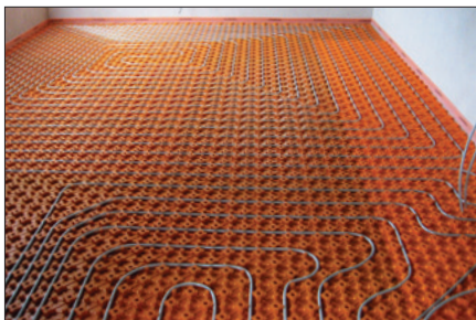
7. Nach der Austrocknungszeit (je nach Einbaudicke 3–10 Tage*) kann Schlüter®-BEKOTEC-THERM verlegt werden. *Je nach Temperatur und Einbaudicke.
