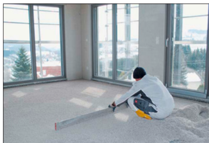
5. ... und ebenflächig verlegt.
